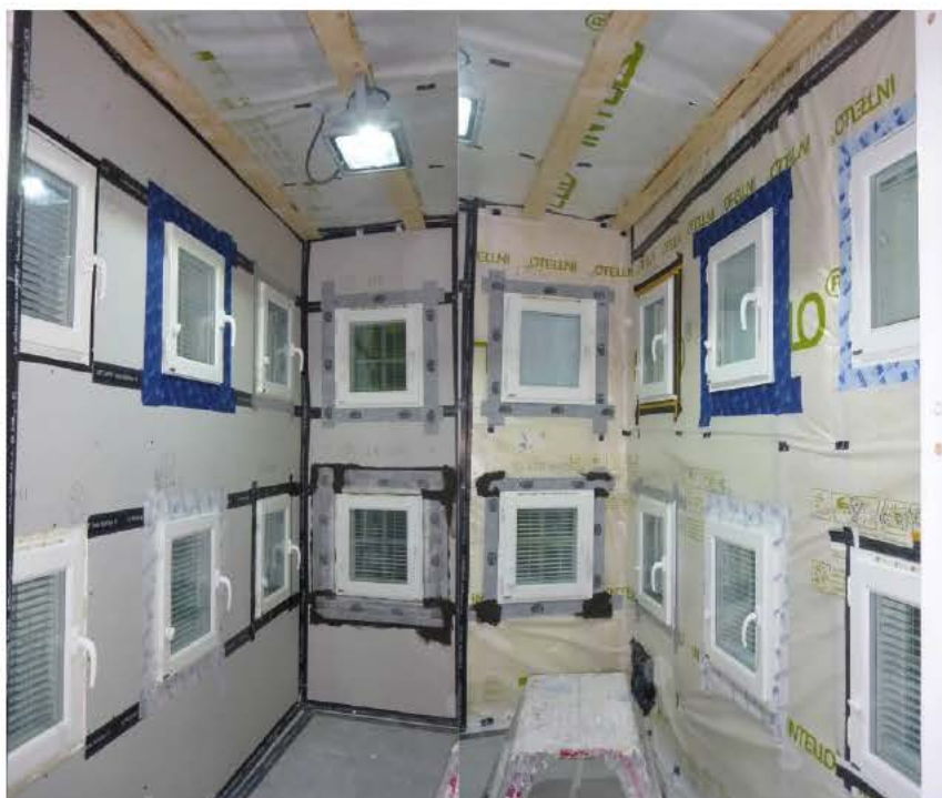
Kuva 11. Yleiskuva testirakennuksen sisäpuolelta ja liitosnauha-asennuksia.
