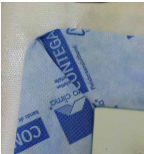
Kuvat 8. Ikkunan ylänurkkien nurkkaliitokset toteutettiin venyttämällä nauhaa siten, että liimapinnan tartunta höyrynsulun pintaan toteutui koko matkalta.
