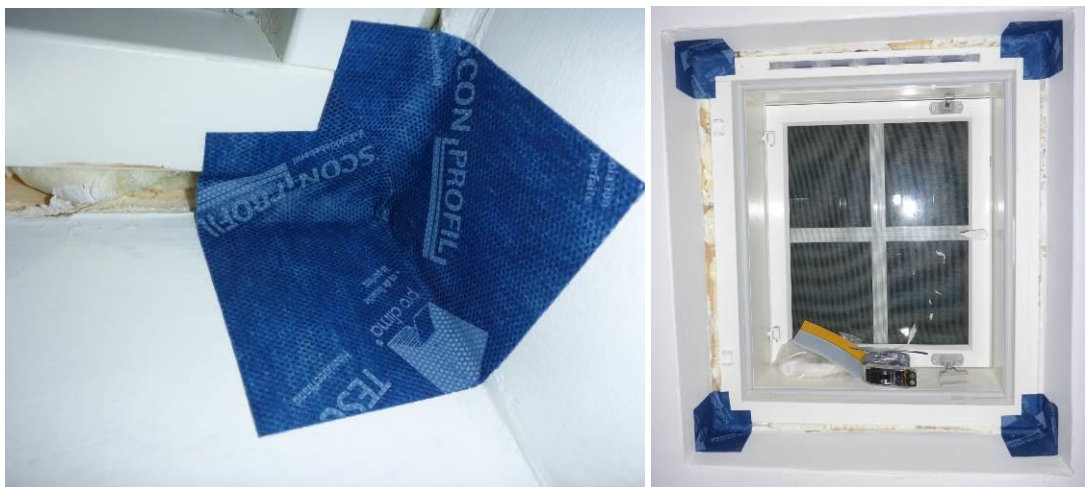
Kuvat 2 ja 3. Ikkunan nurkkaliitokset toteutettiin asentamalla nurkkakohtiin erilliset, muotoillut Tescon Incav –nurkkakappaleet.
