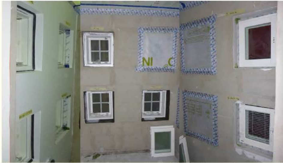
Kuva 8. Yleiskuva testirakennuksen sisäpuolelta ja liitosnauha-asennuksia.
