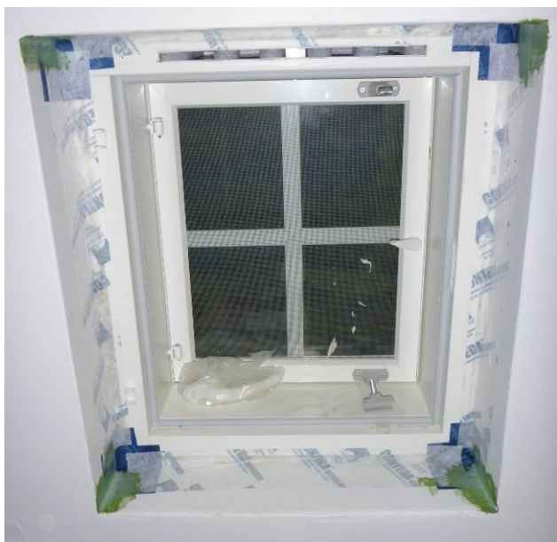
Kuva 1. Ikkunaliittymän tiivistys harkkorakenteisen seinän ikkuna-aukon pielten pintaan toteutettuna Contega Solido SL –liitosnauhalla.
