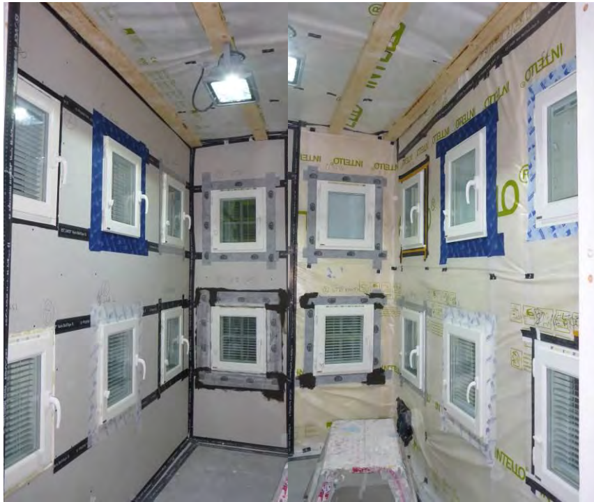
Kuva 5. Yleiskuva testirakennuksen sisäpuolelta ja liitosnauha-asennuksia.
