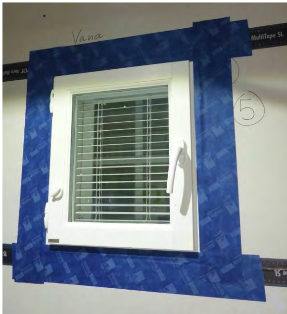
Kuva 1. Ikkunaliittymän tiivistys kipsilevyn pintaan toteutettuna Tescon Vana –yleisteipillä
